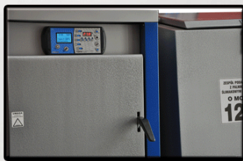
na izolacji kotła
